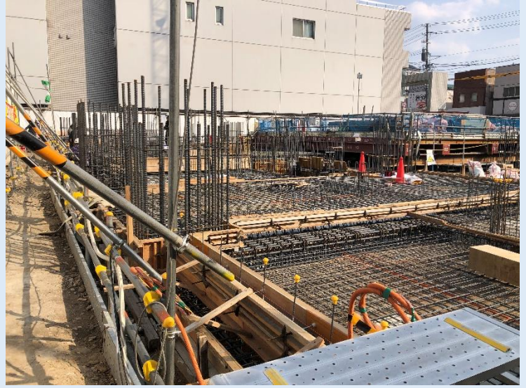
青葉区荒町 現場（型枠）
