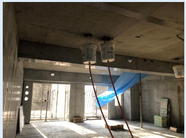
青葉区二日町 現場（型枠）
