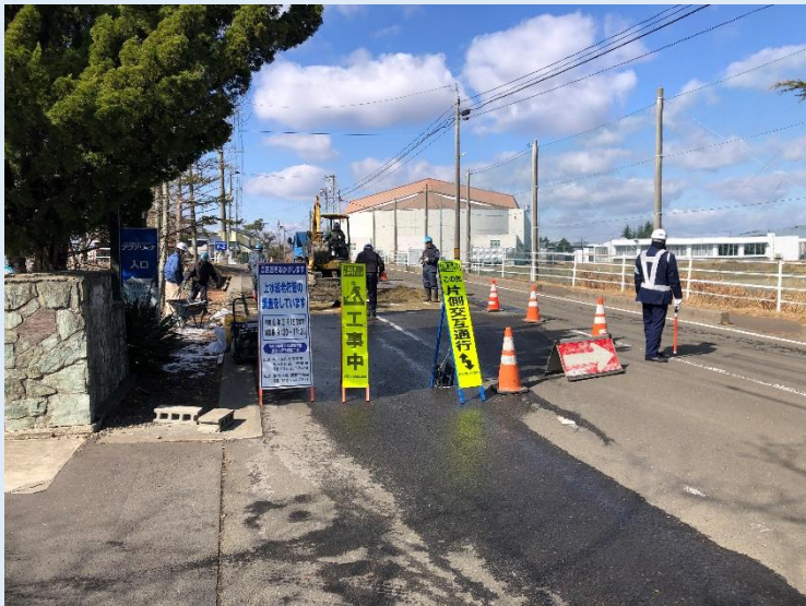
七ヶ浜町吉田浜 現場（土木）
