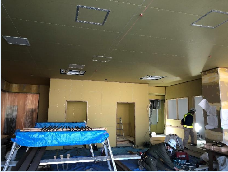
多賀城市中央 現場（建築）
