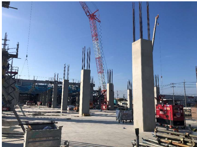
岩沼市内（型枠）
