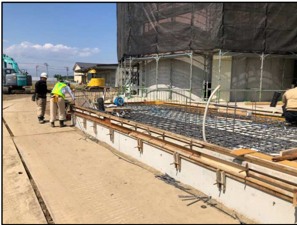
角田市角田町現場
