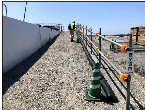
石巻市潮見現場
