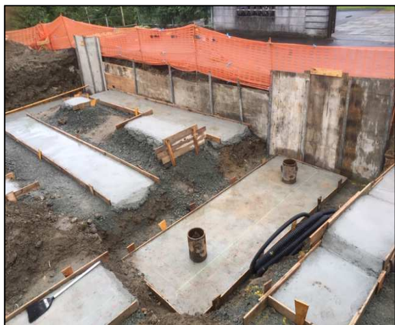
多賀城市笠神現場(1)
