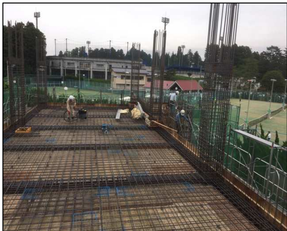
多賀城市鶴ヶ谷現場(1)
