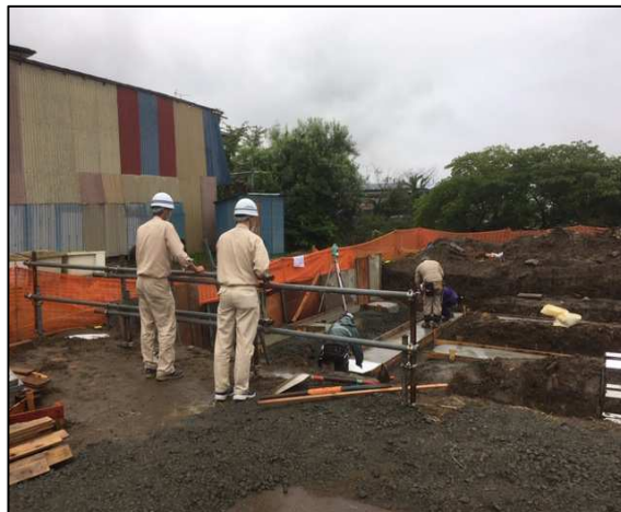
多賀城市笠神現場(2)
