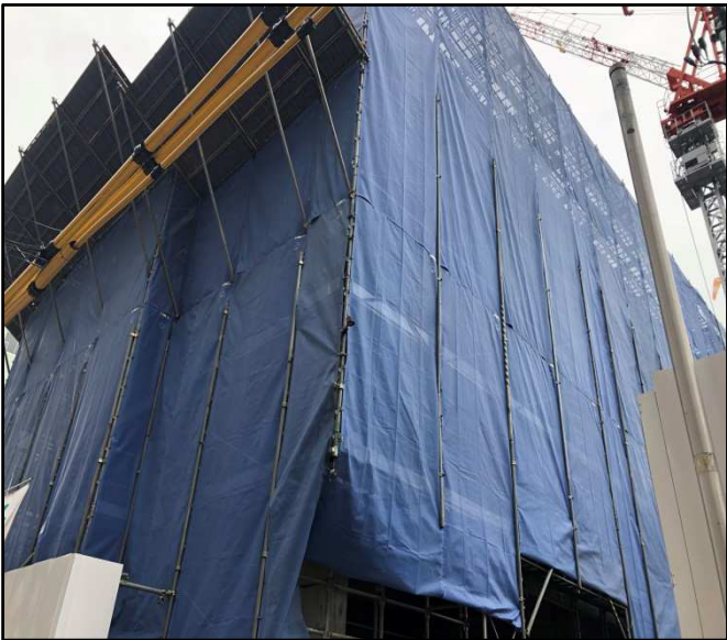
青葉区本町現場
