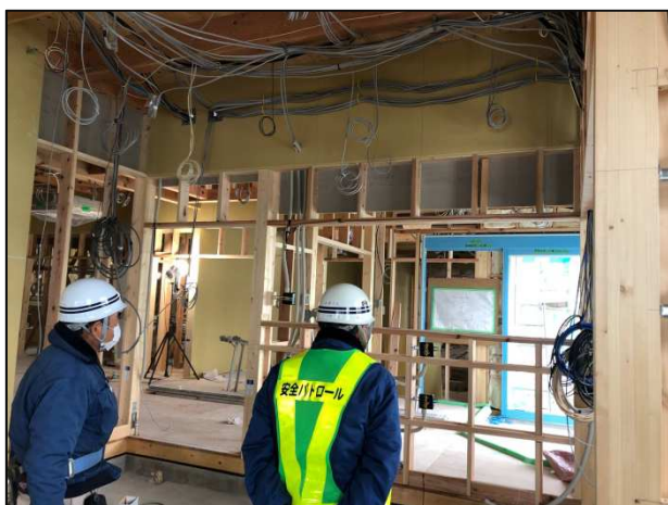
多賀城市笠神現場
