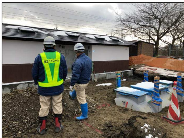
多賀城市浮島現場
