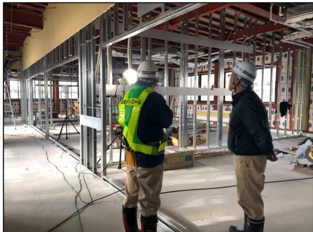
多賀城市城南現場
