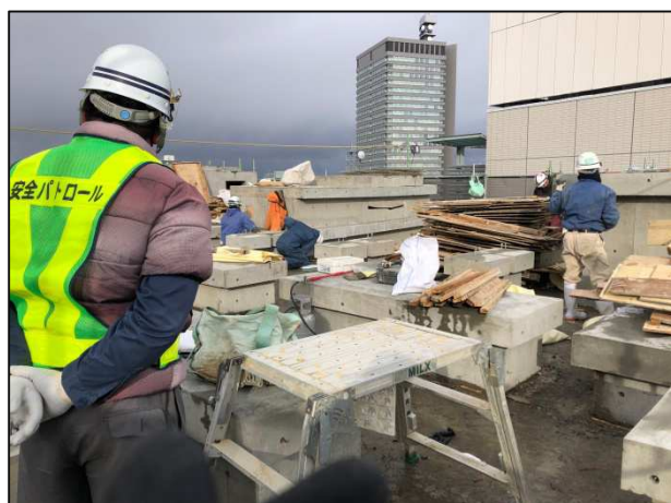
仙台市青葉区現場
