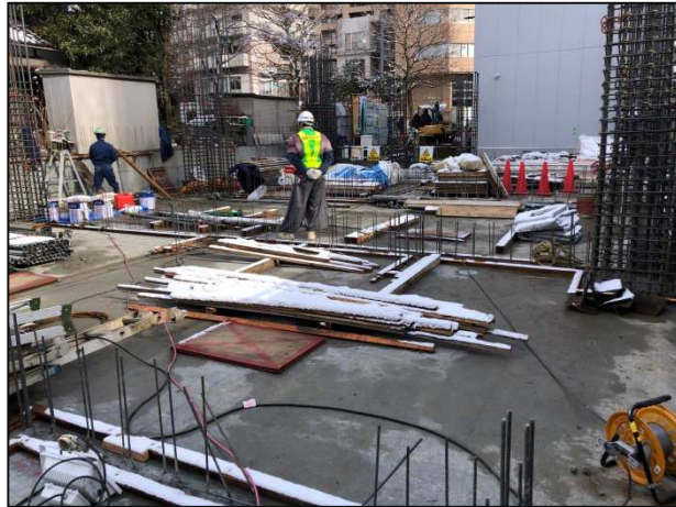
仙台市一番町現場
