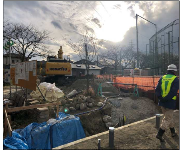
多賀城市浮島現場
