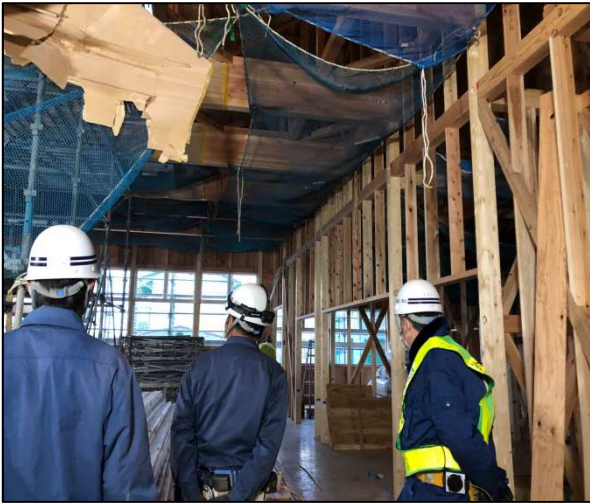
多賀城市笠神現場
