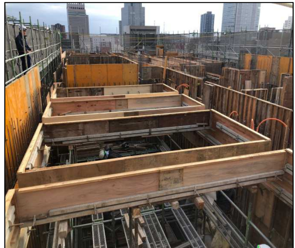
仙台市青葉区現場
