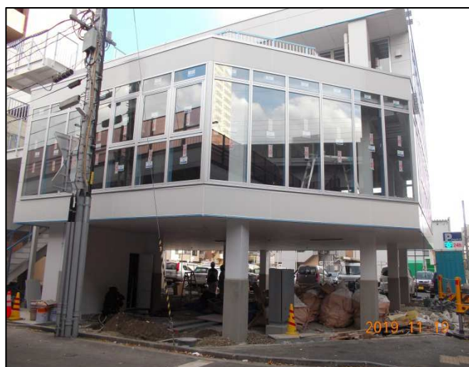
宮城野区現場
